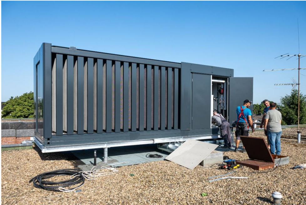
Bildunterschrift 2: Auf dem Flachdach der Sennestraße in Dortmund-Körne wird der Wärmepumpen-Cube angeschlossen.
