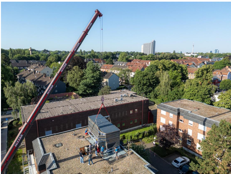
Bildunterschrift 1: Mit einem Kran wird der Wärmepumpen-Cube auf das Flachdach der Sennestraße 11 bis 17 in Dortmund-Körne gehoben. Bildnachweis 1: Vonovia / Bierwald
