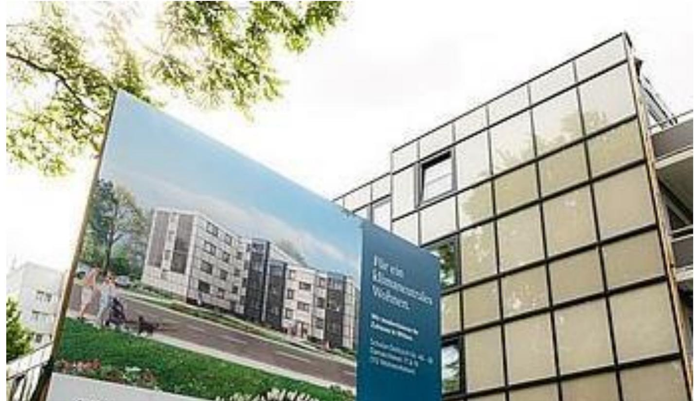
Neben der Photovoltaikanlage unterstützt eine innovative Solarfassade die grüne Stromerzeugung. In den gläsernen Elementen ist eine Wabenstruktur verbaut, die die Sonnenstrahlung nutzt. Auf diese Weise wird im Jahresdurchschnitt so viel regenerative Energie erzeugt, wie die Mieterinnen und Mieter für Heizung, Warmwasser und Haushaltsstrom benötigen.
