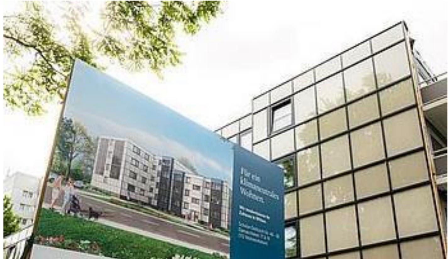
Neben der Photovoltaikanlage unterstützt eine innovative Solarfassade die grüne Stromerzeugung. In den gläsernen Elementen ist eine Wabenstruktur verbaut, die die Sonnenstrahlung nutzt. So wird im Jahr so viel regenerative Energie erzeugt, wie die Mieterinnen und Mieter für Heizung, Warmwasser und Haushaltsstrom benötigen.
